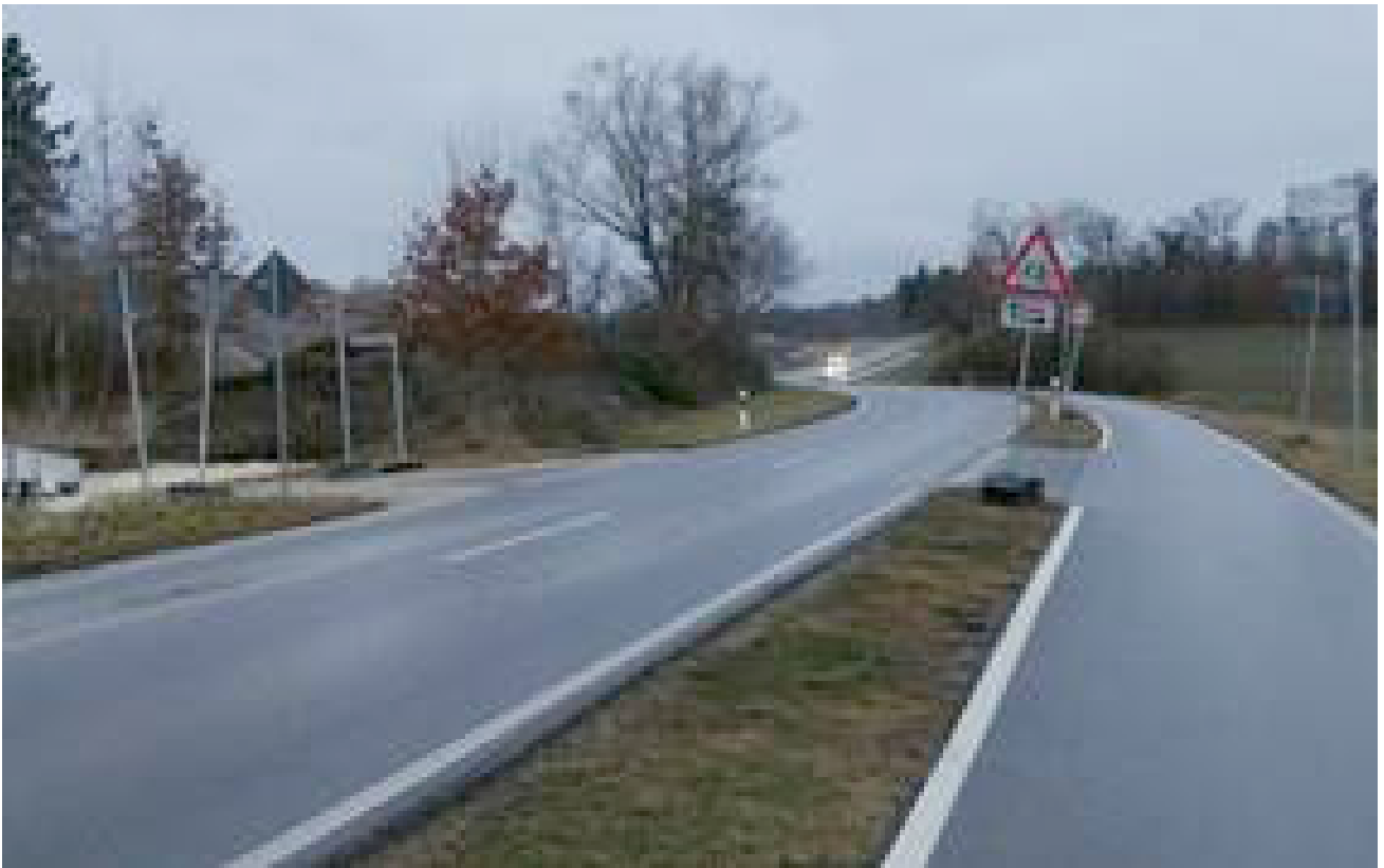
Aktueller Zustand (Richtung Waldsiedlung)
