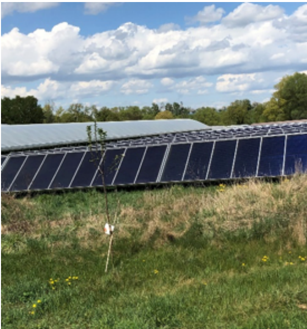
Foto: Kollektor-Anlage in Bohlingen.
